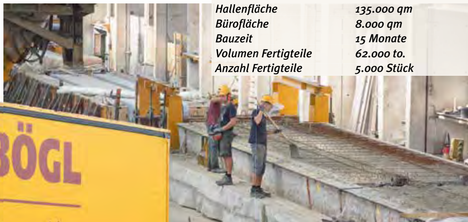
Ein aktuelles Projekt: Schlüsselfertige Erstellung eines voll klimatisierten Logistikkomplexes für einen namhaften Internethandel
